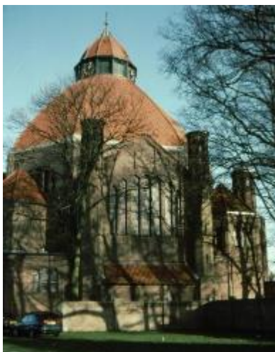
Laurentius Kerk in Dongen van Jos Cuypers en Pierre jr. Cuypers, 1917-1921, in neo-byzantijnse stijl. Met Jan Stuyt nam Jos Cuypers afstand van de Neo-Gotieken bouwde originele koepels in baksteen met spaarzaam gebruik van gewapend-beton-technologie.
