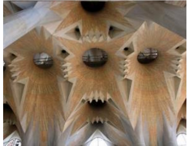
Sagrada Família van Antoni Gaudí. Gewelven in gewapend beton met baksteen in de vorm van een Hyperboloid (koeltoren) en Hypars. Foto JT
